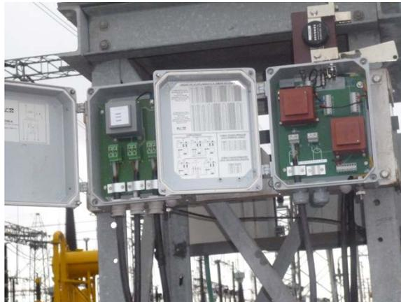
Fotografía 39: Filtros de acoplamiento e híbrido de acoplamiento
