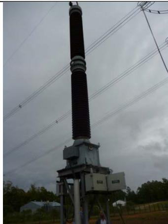
Fotografía 38: Elementos de acoplamiento onda portadora (CCTV/capacitor acoplamiento)
