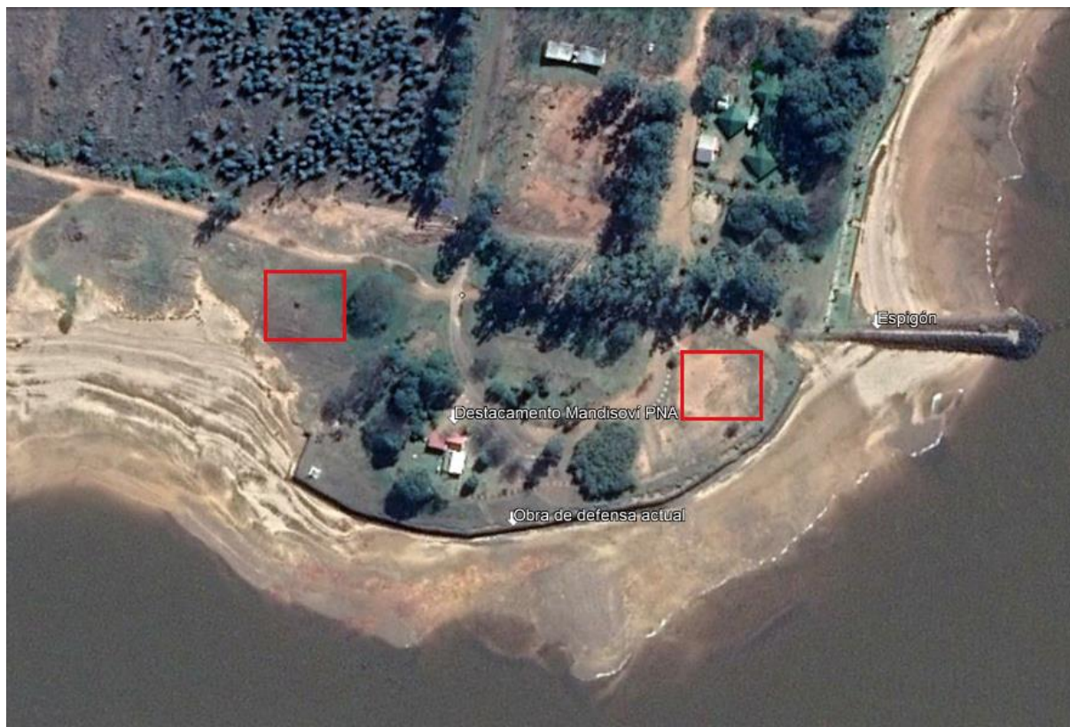
Imagen 1 Posibles sitios de obrador en SANTA ANA.
