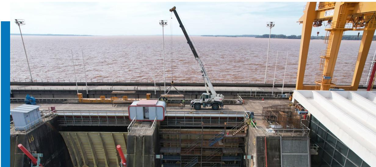
También se ha podido avanzar a buen ritmo con la renovación de los tableros auxiliares de cierre (TAC), pudiendo desmontarlos y luego en los obradores, realizar los diferentes procesos de amolado, grallado, arenado y pintura. Se han podido terminar 15 de los 20 que estaban previstos.
