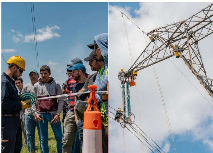
Cuadrilla de Líneas durante el cambio de aisladores en una torre de 500 KW de una fase lateral con doble aislación.
