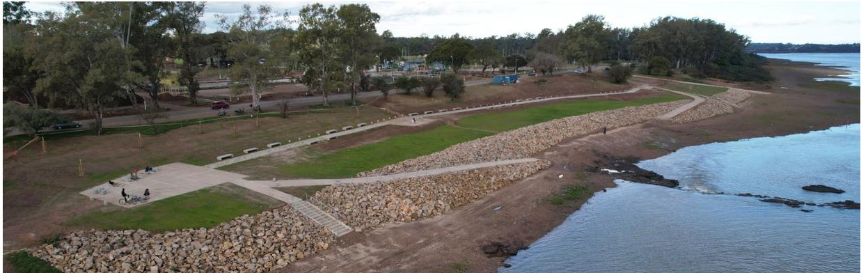
**LOS TRABAJOS EFECTUADOS EN SALTO, CONSISTEN EN UN ENROCADO DE PROTECCIÓN QUE SE PROLONGA POR 300 METROS**
