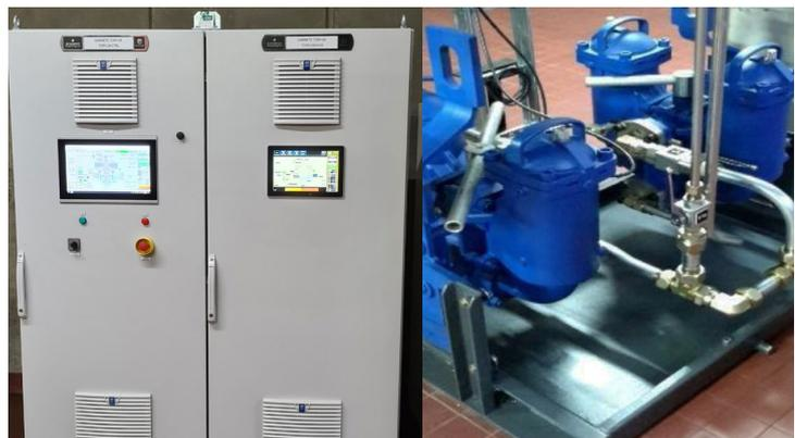
Gabinete regulador de velocidad, Pantalla del SCADA y sistema de filtrado nuevo.
