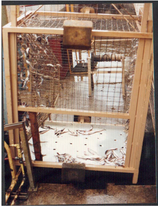
Fig. -13 - Jaula de captura ubicada en la compuerta de salida de las escalas
