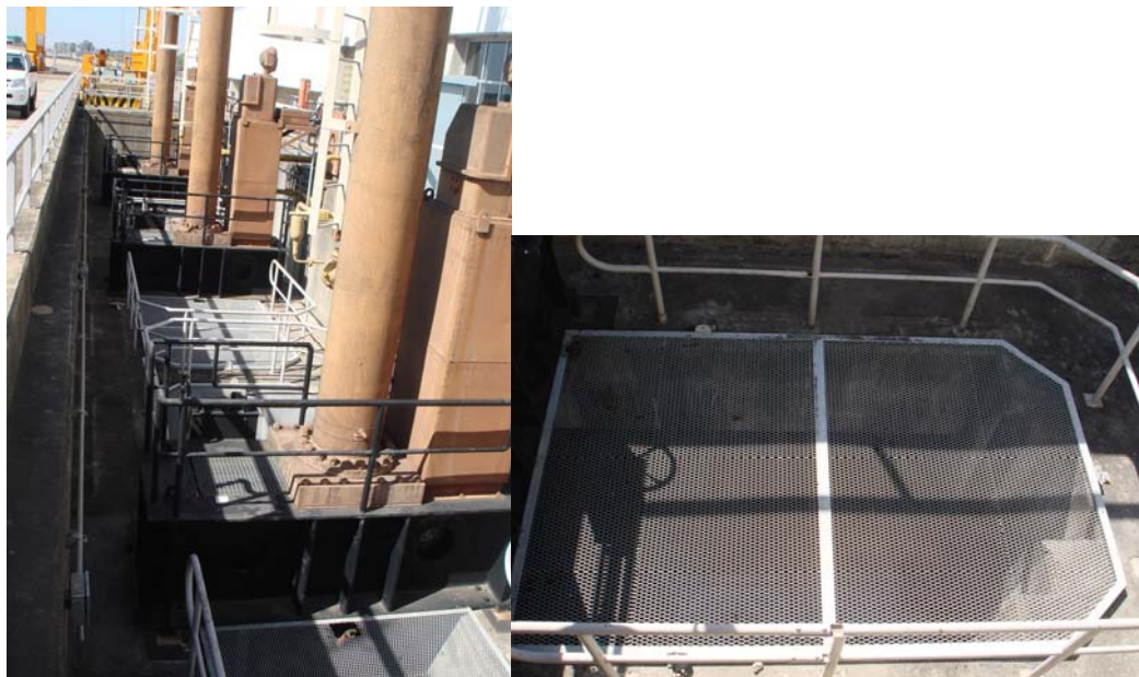
Fig.17 - Detalle de vanos de pozo de compuerta
