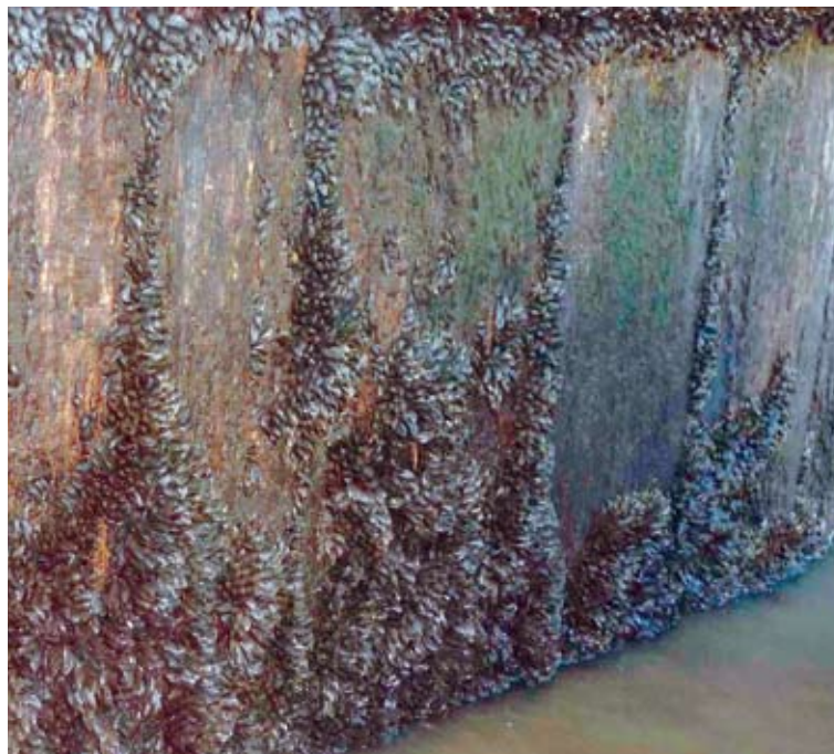
Figura 2. Incrustaciones de mejillón dorado en una superficie dura cerca de Tigre, en el delta del río Paraná.
